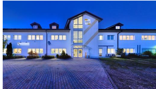
Firmengebäude der esz AG
